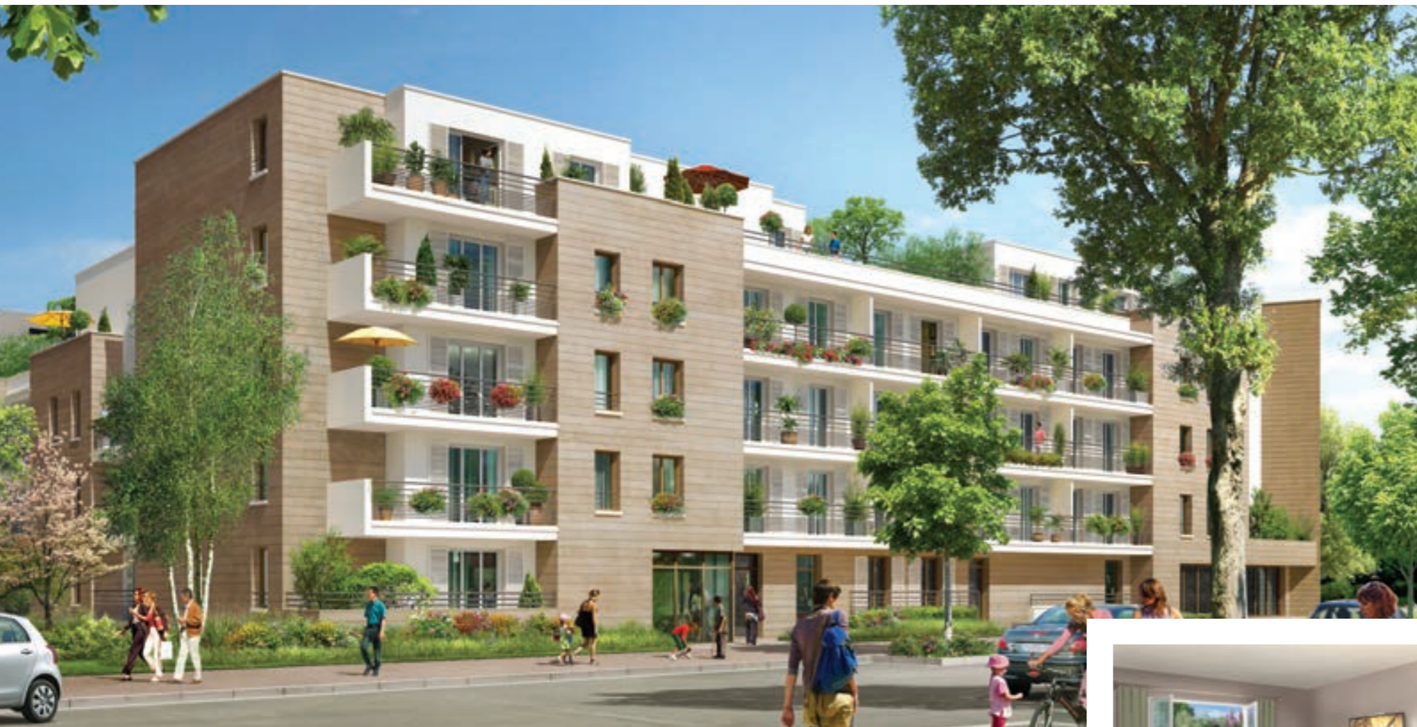
Réalisation "Le Flore & Sens" - Immeuble "Panorama"
